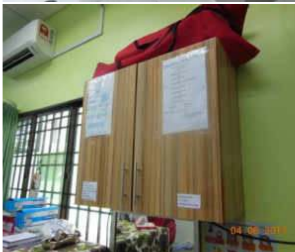
Gambar Sebelum : Contoh kabinet table top dan kabinet gantung yang dibekal tidak berbingkai aluminium Tarikh lawatan: 04.04.2017
