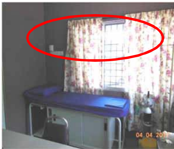
Gambar sebelum: Curtain railing untuk screen coach tidak dibekal di dua (2) bilik pemeriksaan. Tarikh lawatan pada 04.04.2017.
